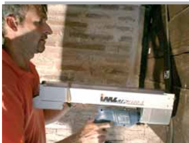
Controlli sullo stato conservativo delle strutture lignee con trapano resistografico
