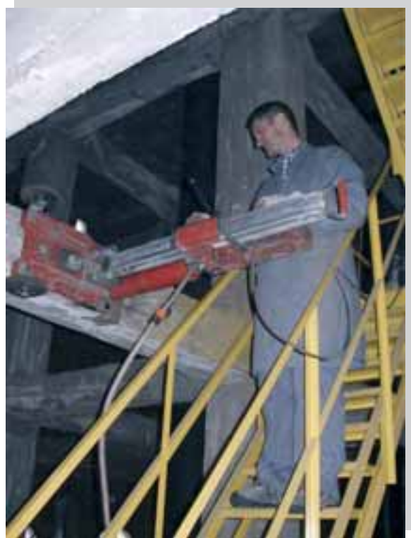
Carotaggio su calcestruzzo
