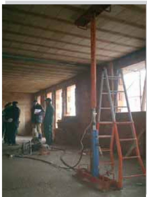
Prova di carico concentrata sui solai a spinta con pistoni idraulici
