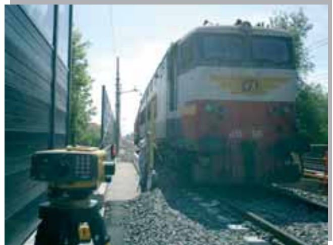
Collaudo di impalcato ferroviario
