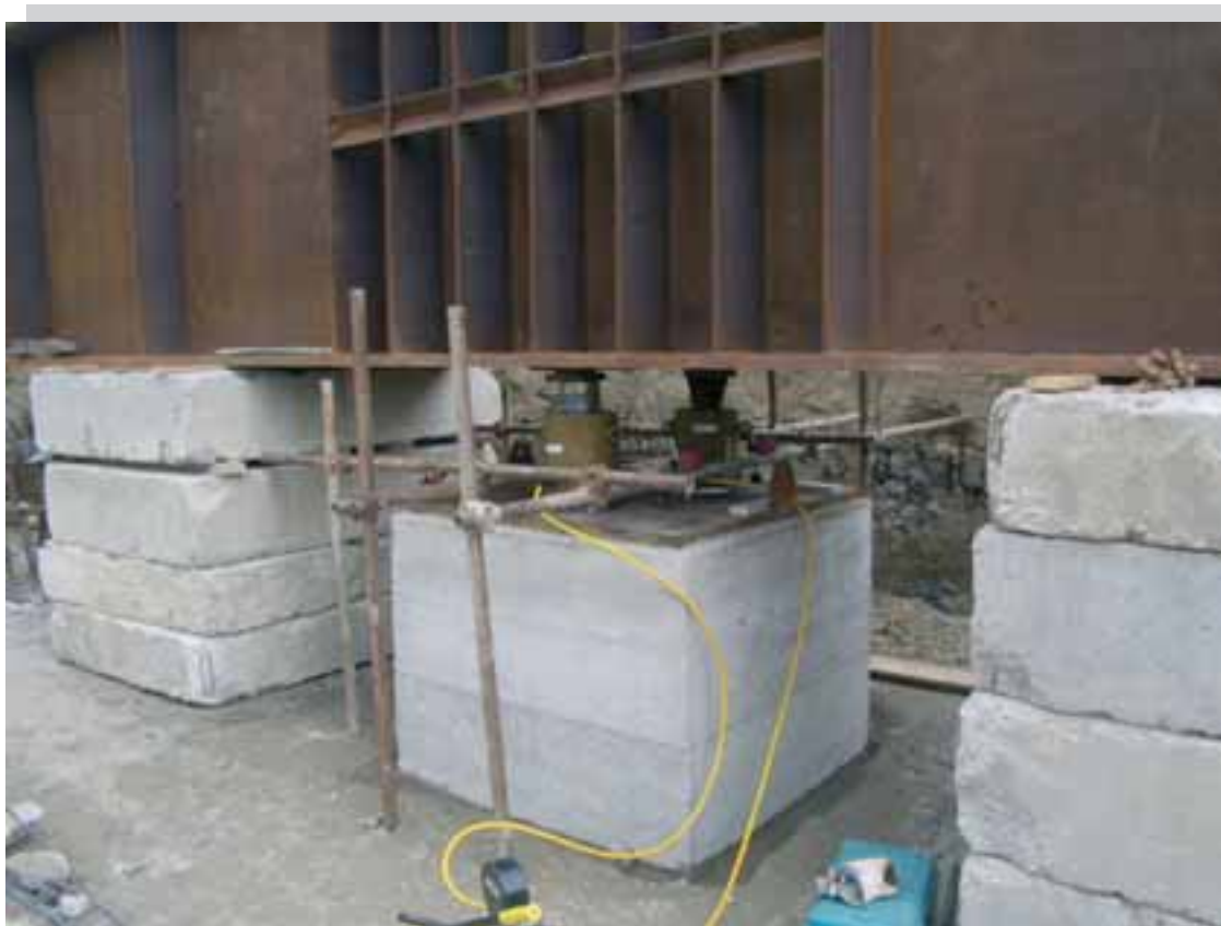
Prova di carico su palo di fondazione
