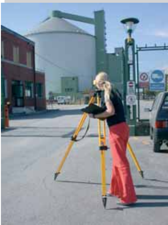
Controllo dei cedimenti del silo
