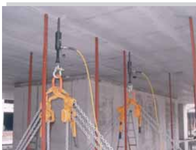
Prova di carico concentrata sui solai a tiro idraulico
